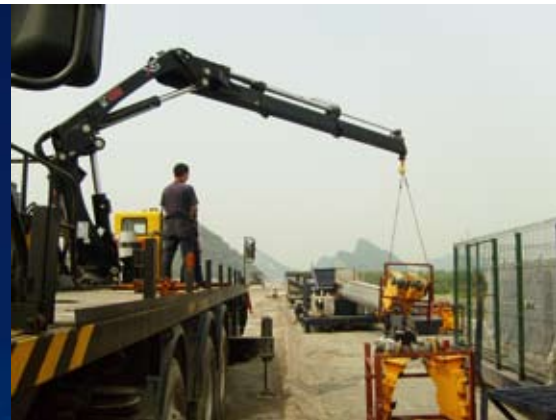
Les grues auxiliaires commandées à distance se sont révélées incontournables en raison de l'hostilité du terrain.
